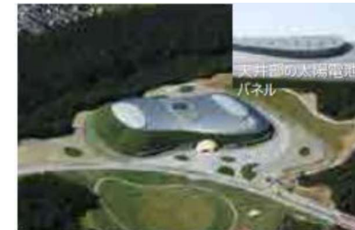
供給型の太陽光発電施設の例 (屋内型運動施設の屋根に設置)
