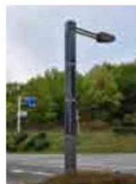
独立型の太陽光発電による照明灯の例
