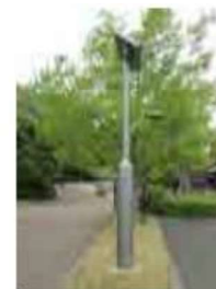
独立型の太陽光発電による照明灯の例
