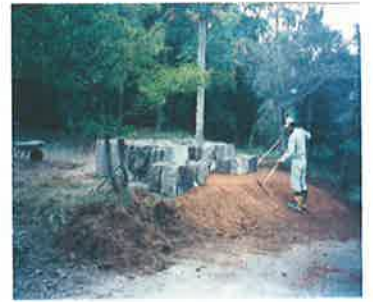
基礎工事完了
