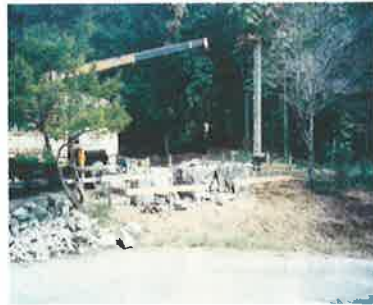
記念碑基礎工事
